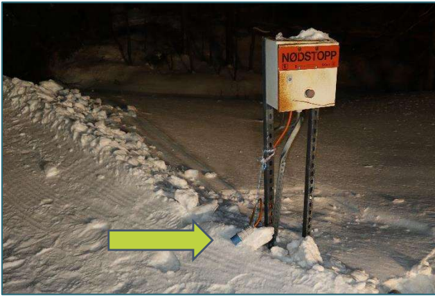
Figur 14: Nødstopknappen og tilkoblingspunktet for nødstoppsnoren. Foto og påtegning: SHK
